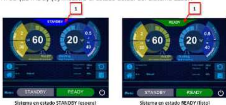
Sistema en estado STANDBY (espera)
