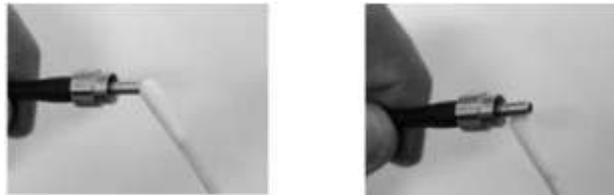
**Paso 3:** Use el otro algodón intercambiable para secar la superficie y los lados del conector.
