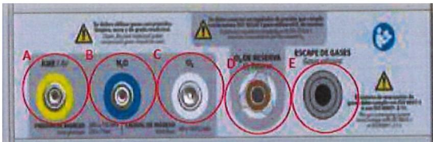
Panel Automatico. (A) Conector de aire medicinal - (B) Conector de N<sub>2</sub>O - (C) Conector de O<sub>2</sub> Medicinal- (D) Conector de O<sub>2</sub> de reserva- (E) Conector de gases medicinales
