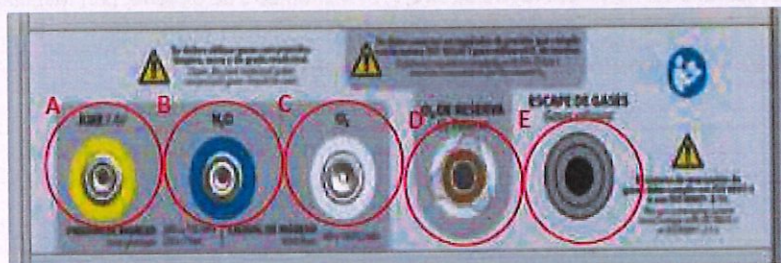
Figura 4: Panel neumático. (A) Conector de aire medicinal; (B) Conector de N 2 O; (C) Conector de O 2 medicinal; (D) Conector de O 2 de reserva; (E) Conector de escape de gases.
